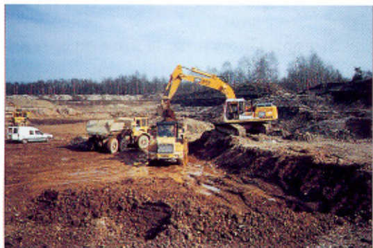
Extraction après rabattement de la nappe
