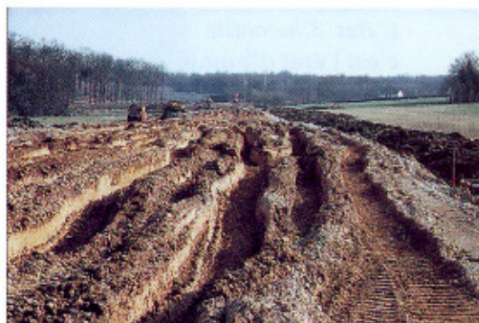
Comportement à la mise en remblai
