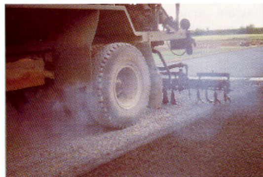
Répandage de l'émulsion.
