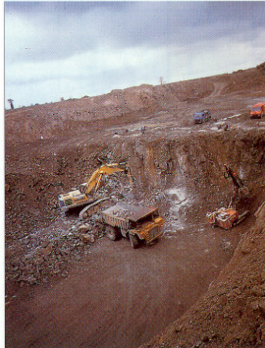
Pour caractériser un déblai rocheux, il faut au préalable être en mesure de prévoir à partir de la roche en place le comportement du matériau après abattage.
