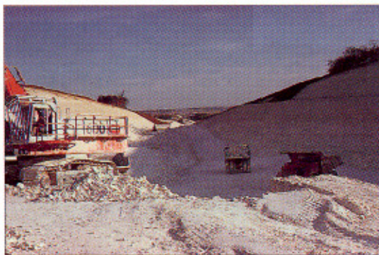
Craie de la classe R_{12m} (craie de densité moyenne à teneur en eau moyenne).
