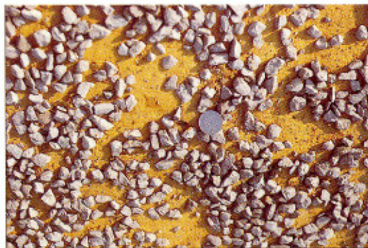
Après épandage des gravillons de cloutage.
